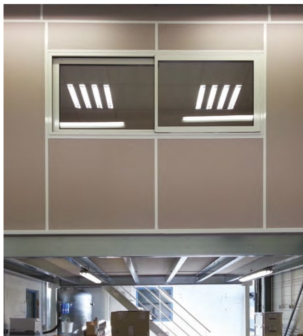
Installation d'un bureau au-dessus d'un atelier de production pour répondre à un accroissement d'activité sans devoir déménager (Absices)
