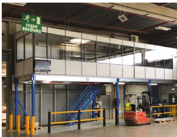
Espace de bureaux installé sur une mezzanine dans un entrepôt logistique pour augmenter la surface au sol. La structure de la plateforme est équipée de barrières à mémoire de forme et de protections de poteaux pour sécuriser les accès (GBG Concept)
