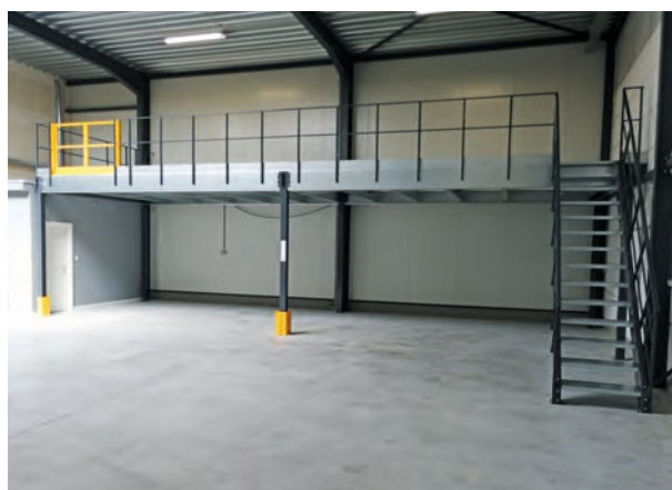
Plateforme en cours d'installation dans un atelier de fabrication, avec alignement du plancher de la mezzanine et celui du bâtiment (Marc Van Ackere)
