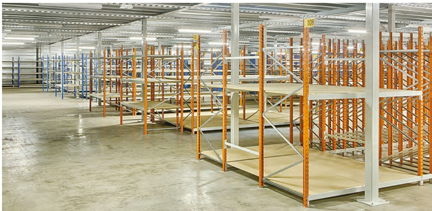
Installation multiple dans un entrepôt pour le stockage de différents types de produits et de volumes
