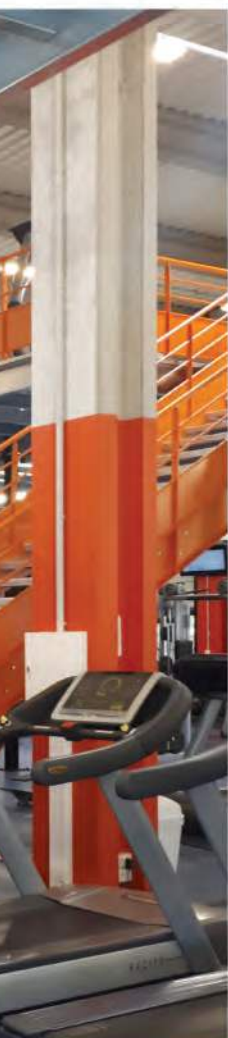
Trap voor tussenvloer, met vol en gekleurd stootbord van de eerste trede. Comfortabele en conforme helling van de treden (DDI Rayonnage)
