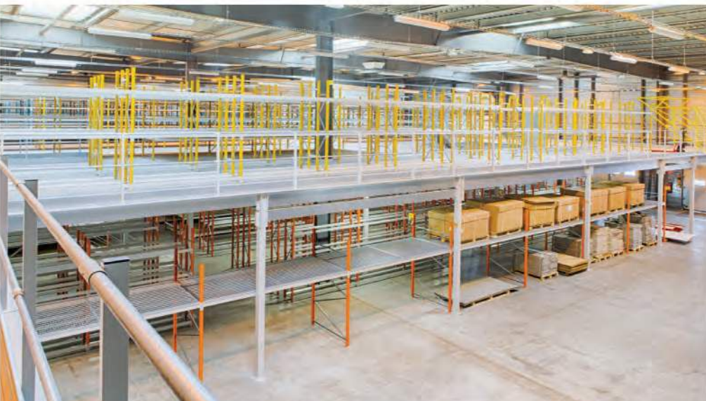
Volledige renovatie van een logistiek magazijn voor auto-onderdelen van 4.000 m 2 , met stellingen geïnstalleerd op en onder de tussenvloer (Spade Equipment)
