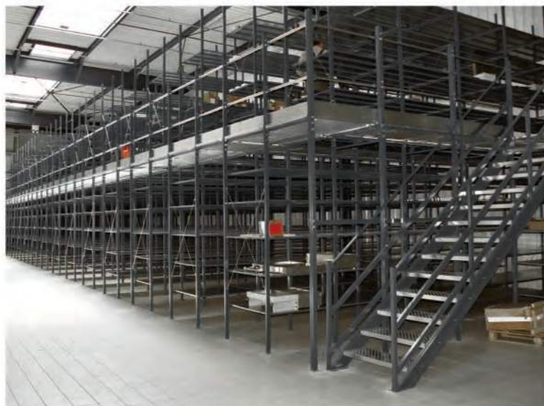
Installatie van stellingen ACTI-PLUS op twee etages om de opslagruimte voor grondstoffen te optimaliseren (Actiflip)
