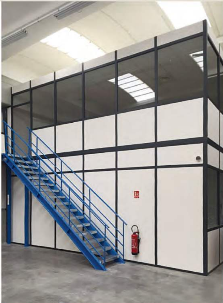
Kantoren en gemeenschappelijke ruimtes op twee etages (Avas Equipement)
