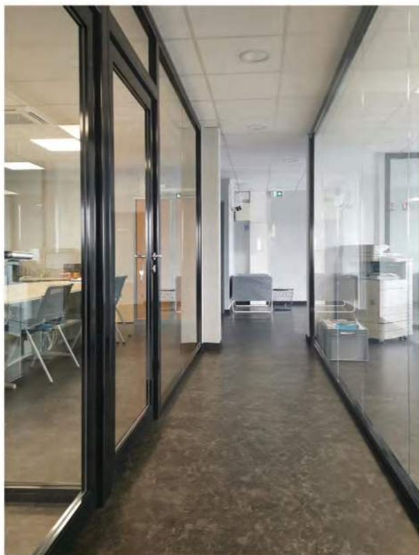
Creëren van kantoorruimtes met glazen scheidingswanden tot aan het plafond (Araydis en GBG)
