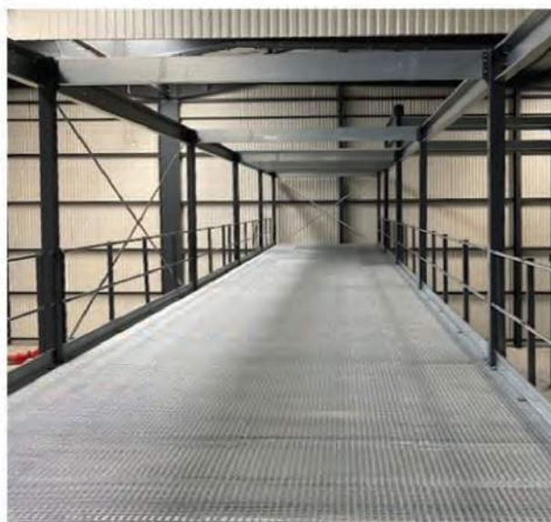
Doorloopvlak met roostervloer, vooral aanbevolen voor gebouwen die zijn uitgerust met branddetectie- en sprinklersystemen (GBG Concept)
