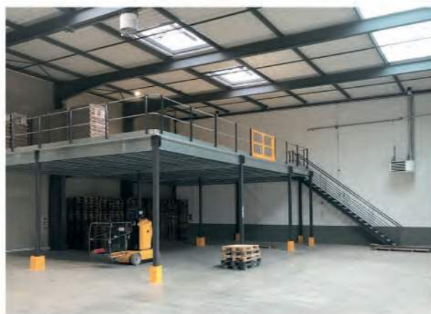
Verdubbeling van de opslagoppervlakte met een tussenvloer voorzien van een leuning en een zelfsluitende klapdeur voor het veilig laden/lossen van pallets op de etage (Araydis)
