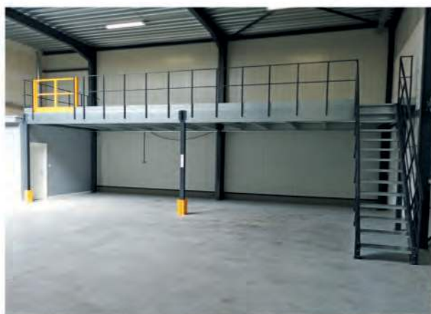
Tussenvloer wordt geïnstalleerd in een productiewerkplaats, waarbij de vloer van de mezzanine is uitgelijnd met die van het gebouw (Marc Van Ackere)
