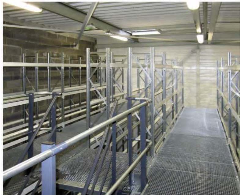
Installatie van dubbelzijdige ACTI·VOL-stellingen voor de opslag van banden over de volledige hoogte van het gebouw, met toegang en een roostervloer (Actiflip)
