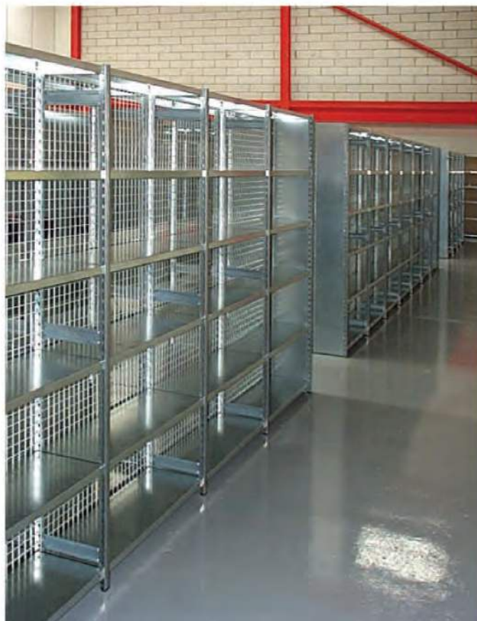
Installatie van dubbelzijdige stellingen, met centrale afscheidingen of achterwanden van gas (Actiflip)
