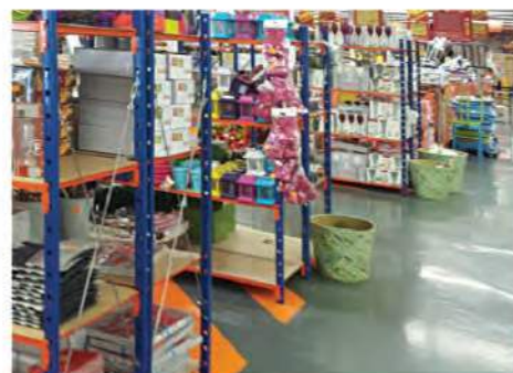
Stellingindeling in een discountwinkel, aangepast in de kleuren van het merk (Spade Equipment)
