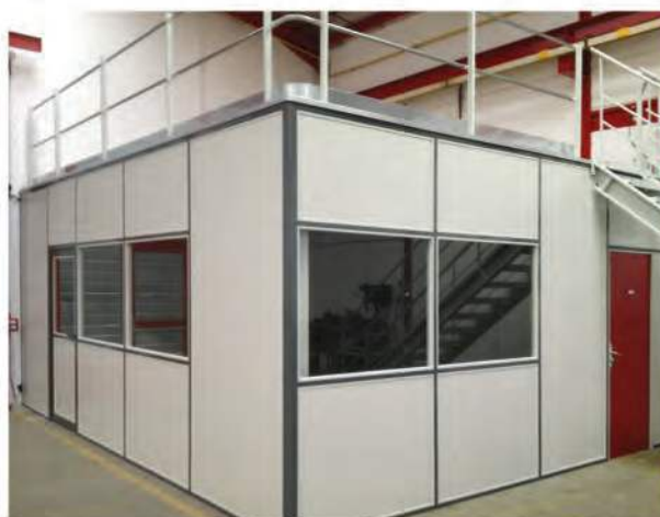
Kantoor voor goederenontvangst, ingericht in de draagstructuur van een opslagvloer voor materieel (Actiflip)
