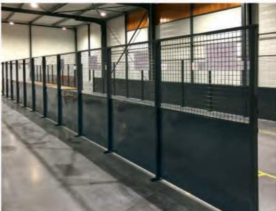
Afbakening van de toegang tussen opslag- en circulatiegebieden in een magazijn (Poitou Rayonnage)
