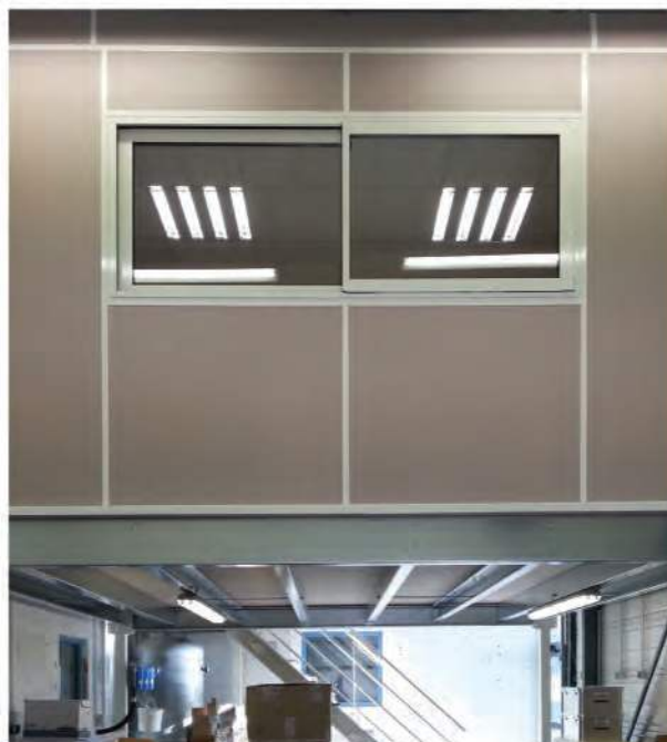
Installatie van een kantoor boven een productiewerkplaats om een toename van activiteiten op te vangen zonder te hoeven verhuizen (Absices)
