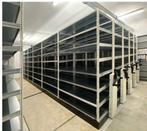
Gemengde installatie van mobiele stellingen op rails en vaste stellingen, 6 rijen (Optim'Est)
