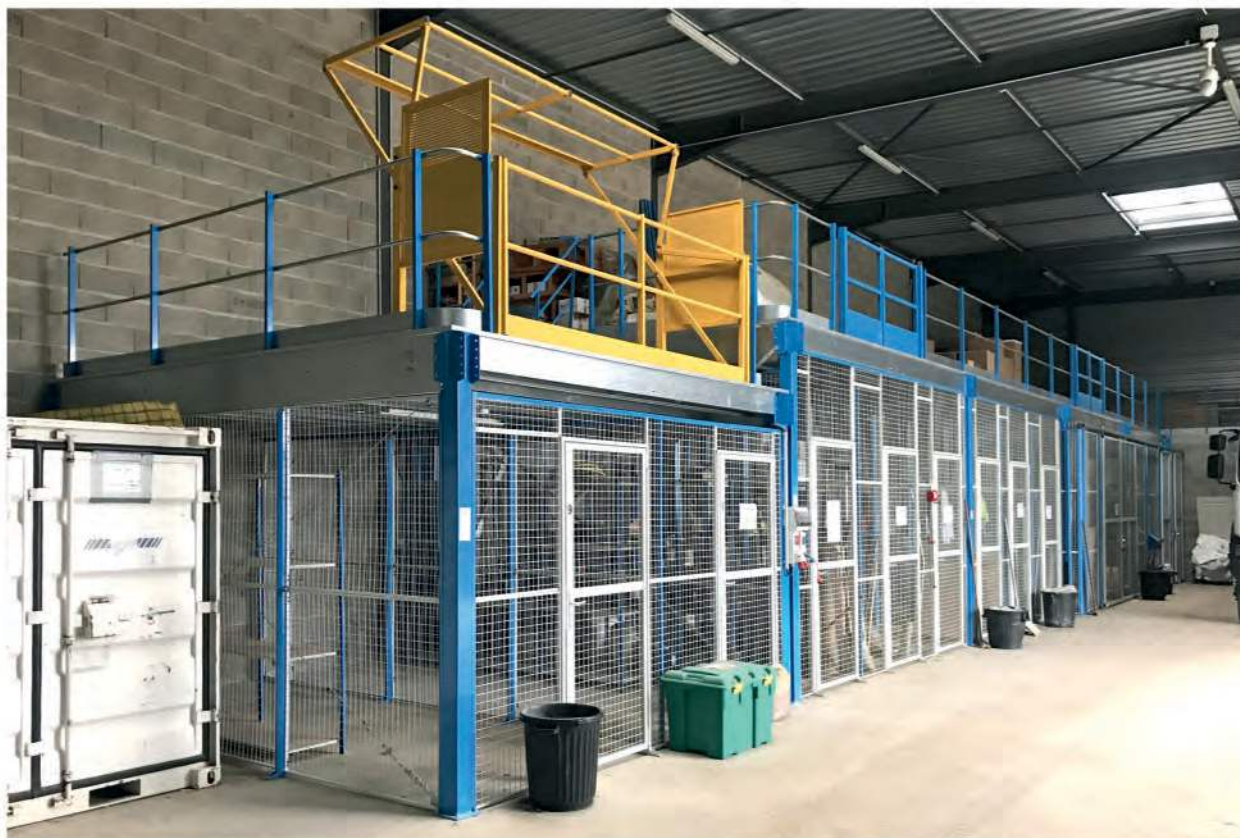
Beveiliging van onderdeelvoorraden onder een tussenvloerstructuur (Araydis)
