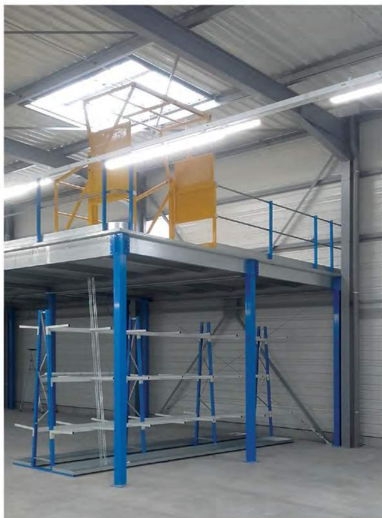
Werkplaats uitgerust met een mezzanine en een rek voor verticale kokers ACTI-VOL dubbelzijdig (DDI)
