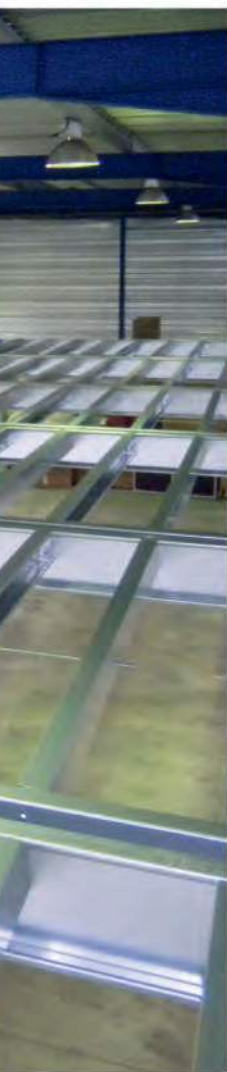
Tussenvloer wordt geïnstalleerd in een productiewerkplaats, waarbij de vloer van de mezzanine is uitgelijnd met die van het gebouw (Marc Van Ackere)
