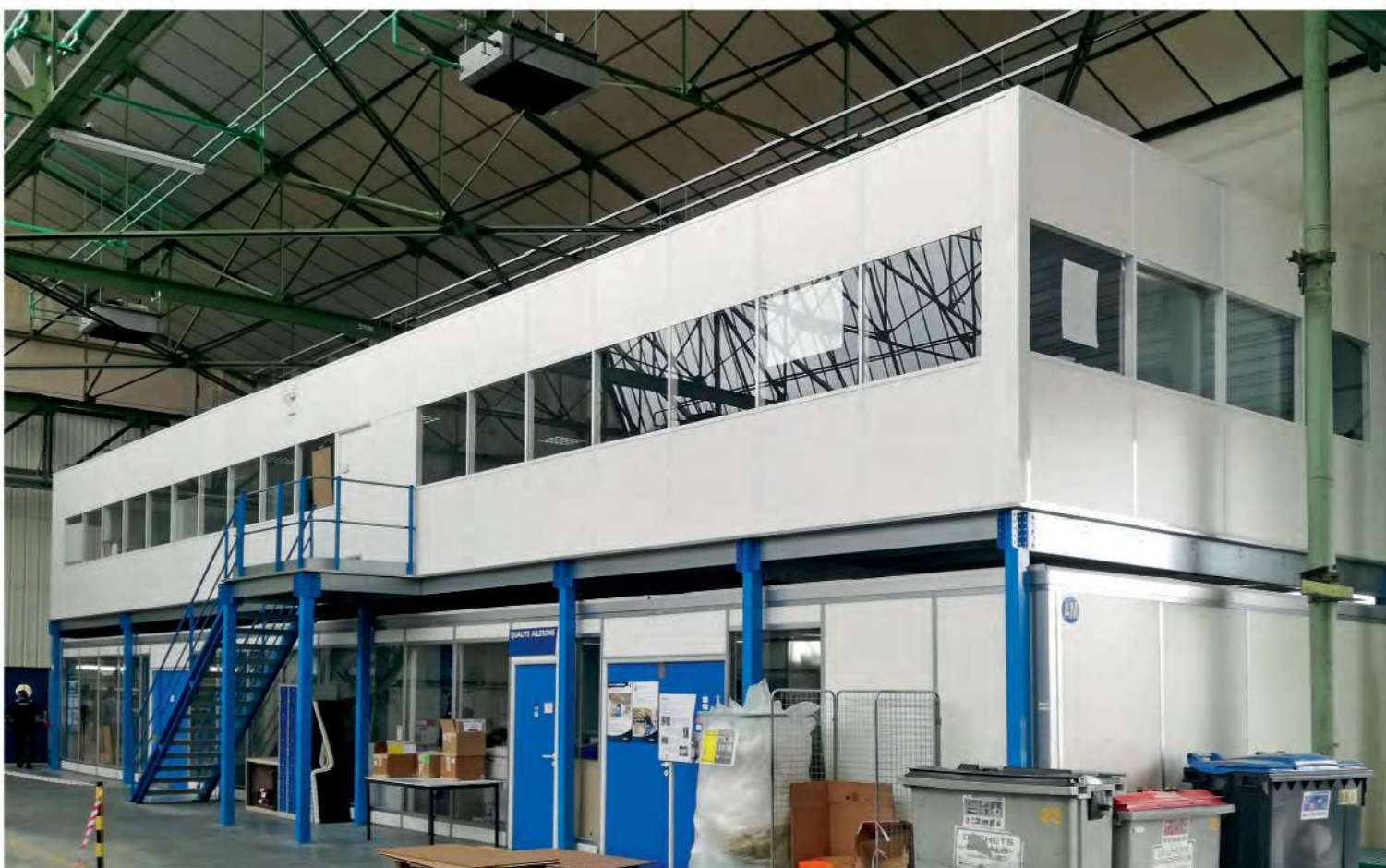
Benutten van de hoogte van een gebouw om kantoren toe te voegen op een tussenvloer boven bestaande kantoren (Merial Bordeaux)
