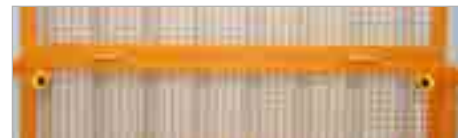
ankerpunten voor PBM (Persoonlijke beschermingsmiddelen) (MB-B, MB-CH)
