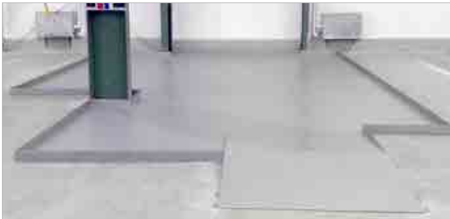
Bodembeschermbekledingen met uitsparing voor pijlers en overrijdplaten
